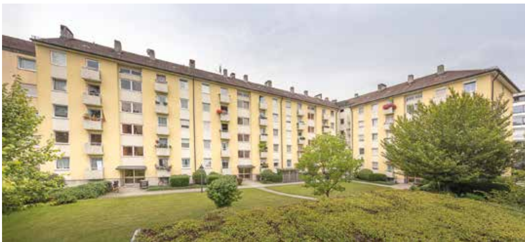
Wohnanlage Ost, Trausnitzstraße 20-28
