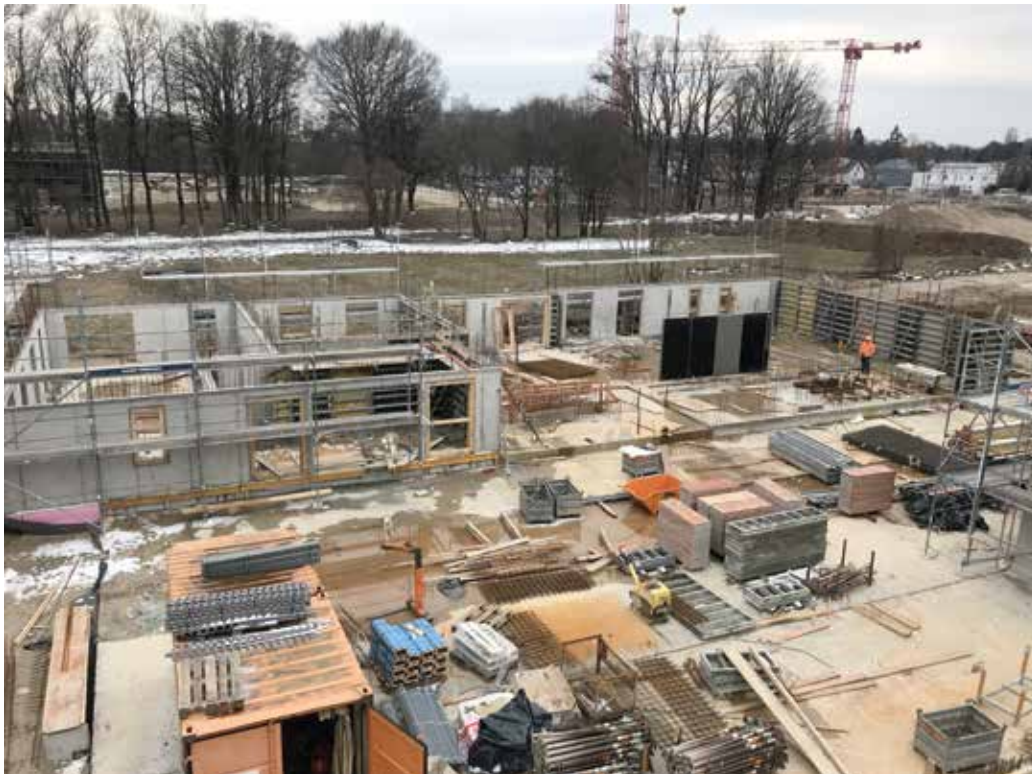
Wohnanlage Prinz-Eugen-Park, Gebäude 2, Bau der Wände im Erdgeschoss (Stand: 19.03.2018)
