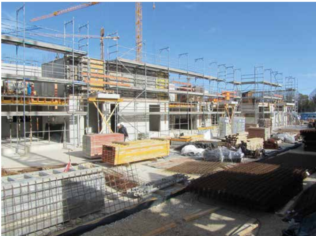
Wohnanlage Prinz-Eugen-Park, Gebäude 1, Bau des ersten OG (Stand 12.04.2018)
